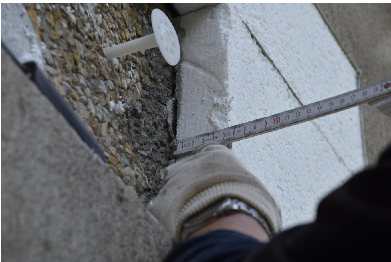
Detail – změřená tloušťka použitého izolantu – 50 mm.
