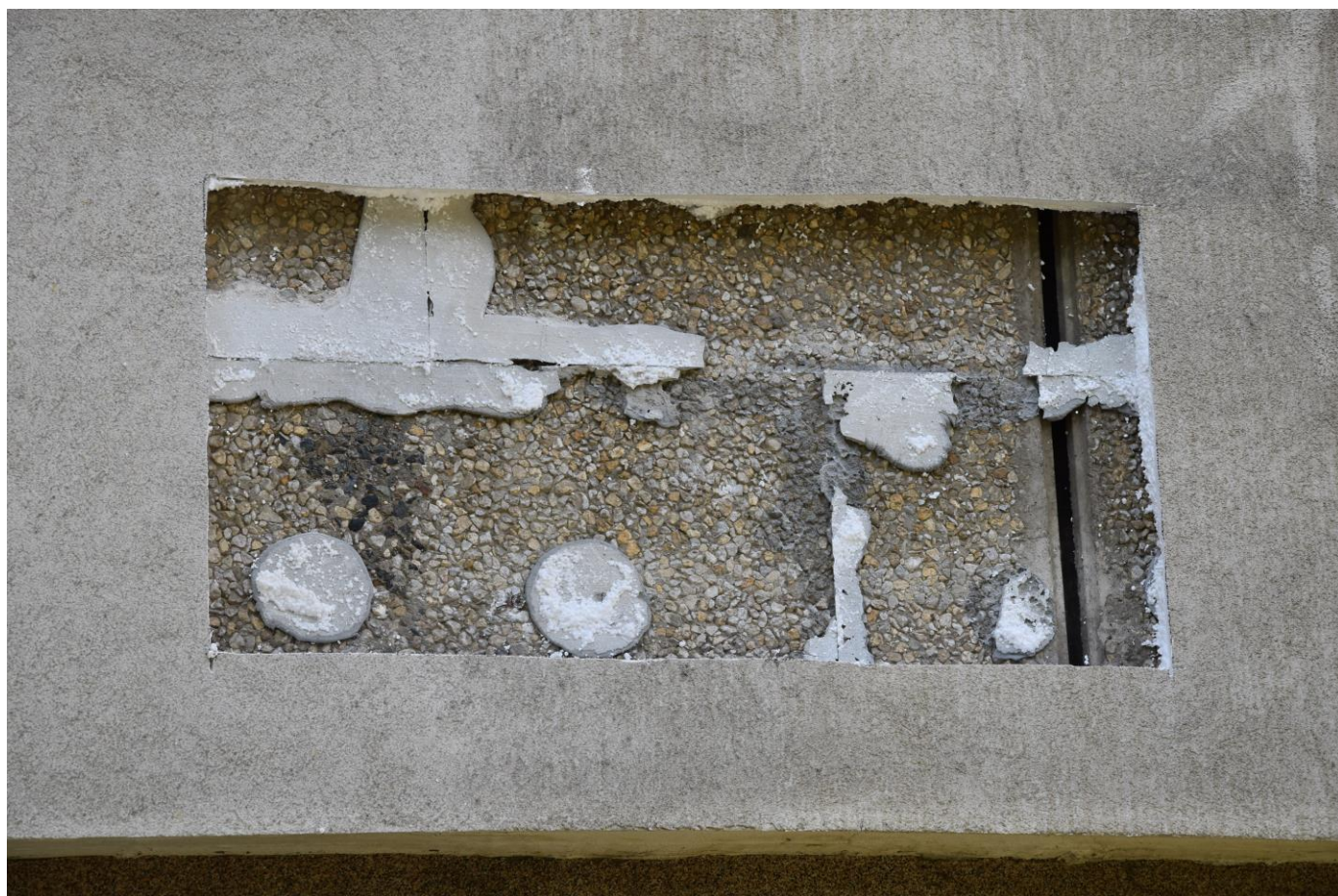
Detail - lepicí tmel na podkladu – použitá metoda rámeček a 3 terče.
