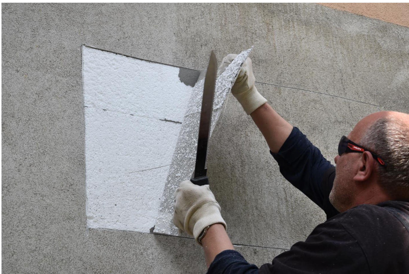
Odstraňování základní výztužové vrstvy.
