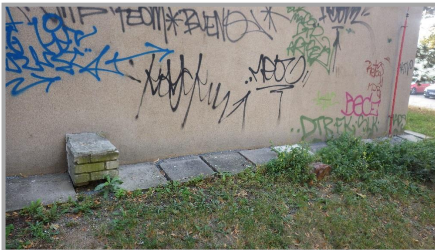
Obrázek č.6. : (Stávající okapový chodník kolem objektu)
