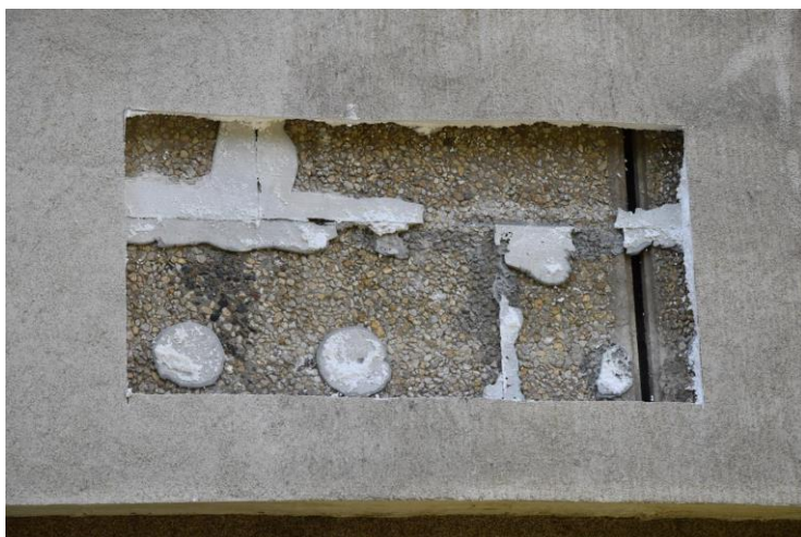
Obrázek č.3. : (Provedená sonda do konstrukce ETICS)
